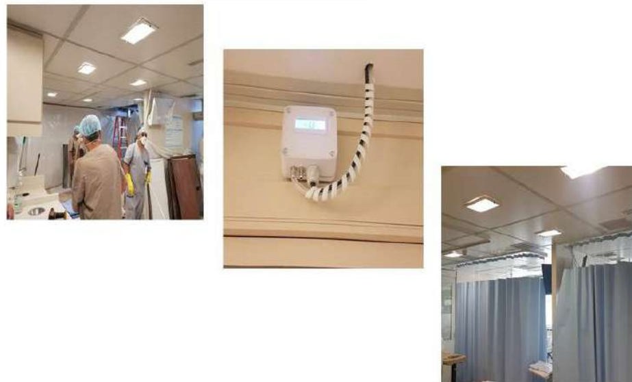
Execução do projeto em leitos sem pressão negativa.
