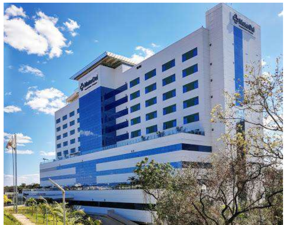
Fachada do Hospital Mater Dei Betim Contagem
