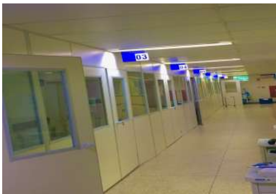
Imagem 2: Disposição dos leitos em divisórias navais instalados pelo departamento de Infraestrutura no setor da UTI Adulto.
